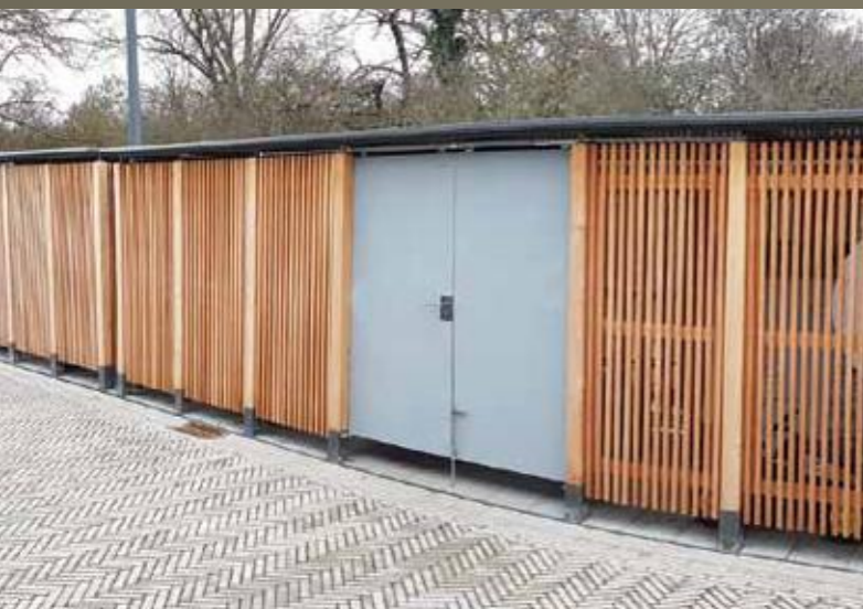
GERÄTEHAUS – Schule Würzburg
